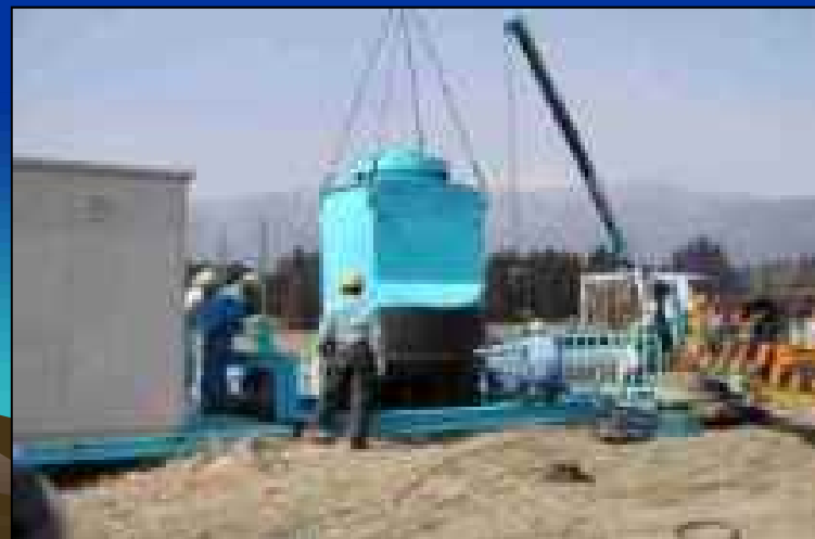
④架台の上に水車発電機を設置
